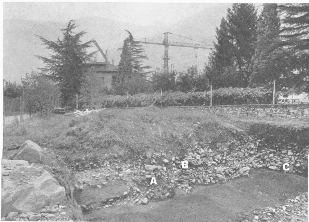
Fig. 1 - Il cantiere in località Jauch (da SO). A = Riempimento di pietrame con funzioni di drenaggio; B = Muro Ovest; C = Muro Est.
